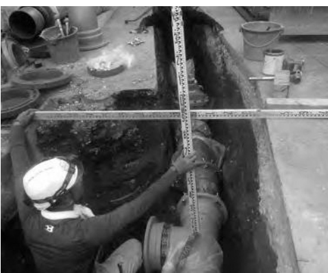
水道管の耐震化工事
