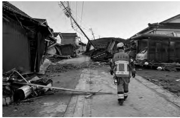
能登半島地震で倒壊した木造建物
