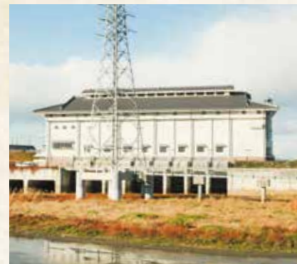
巨椋池排水機場
