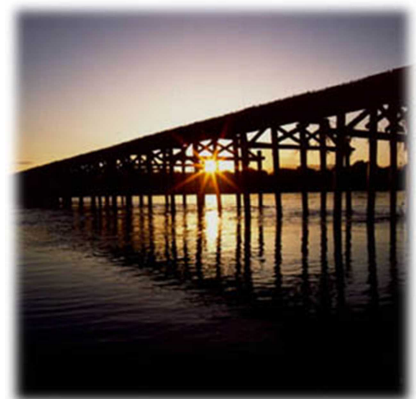
木津川流れ橋
