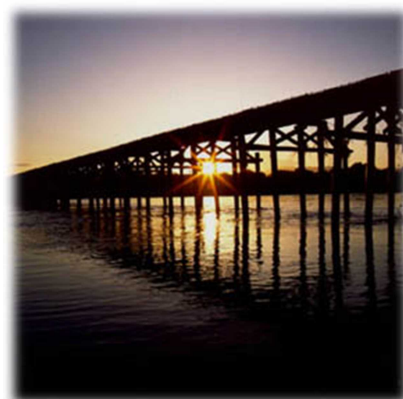
木津川流れ橋
