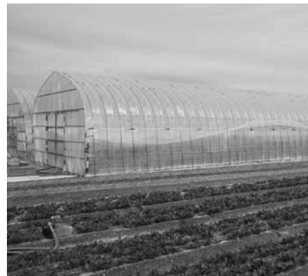
復旧されたパイプハウス
