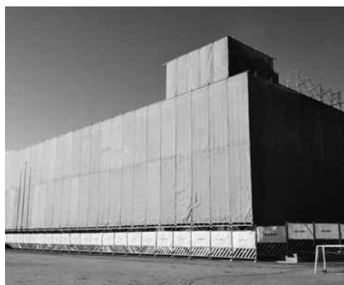
足場で覆われた中学校南校舎
