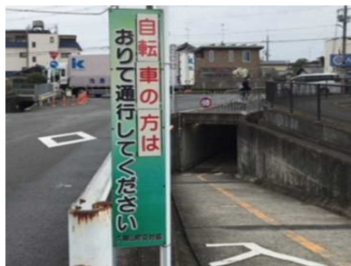
⑦ 看板の補修
