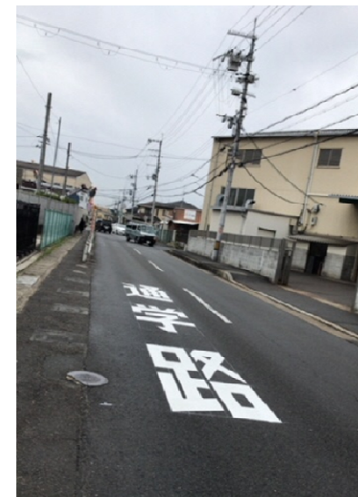
⑪ 路面標示の設置
