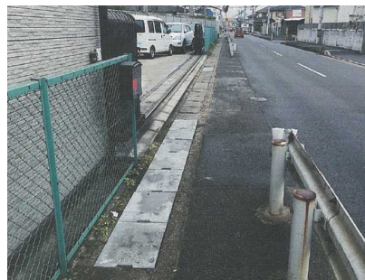
⑪ 溝蓋の補修
