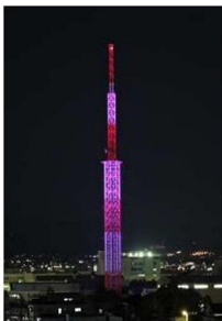
<KBS電波塔> 南ランドマーク
