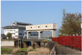
<巨椋池排水機場>
