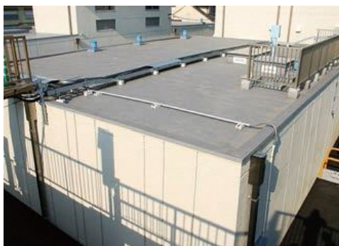
写真 2.6 佐古浄水場配水池
