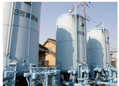
写真 2.5 急速ろ過機
