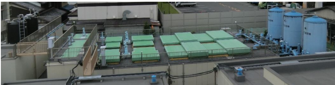
写真 2.1 佐古浄水場浄水施設全景
