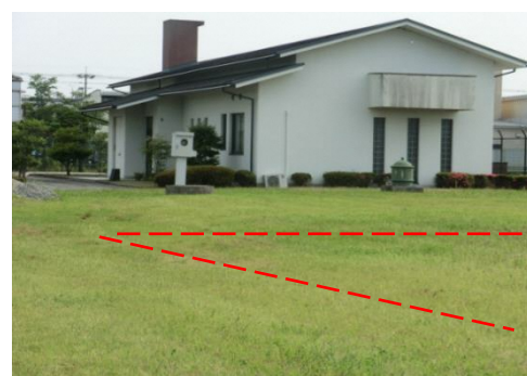
写真 2.9 北浦配水場配水池（地下）
