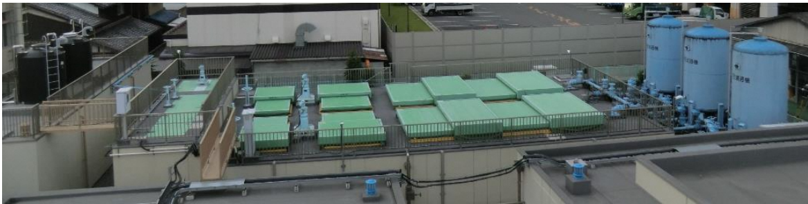
写真 2.1 佐古浄水場浄水施設全景
