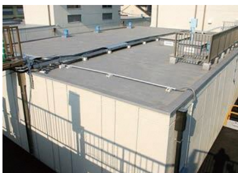
写真 2.6 佐古浄水場配水池
