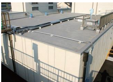
写真 2.6 佐古浄水場配水池
