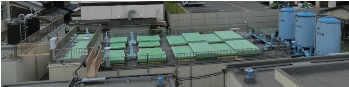
写真 2.1 佐古浄水場浄水施設全景
