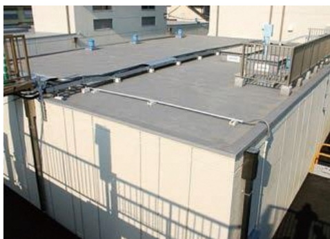
写真 2.6 佐古浄水場配水池
