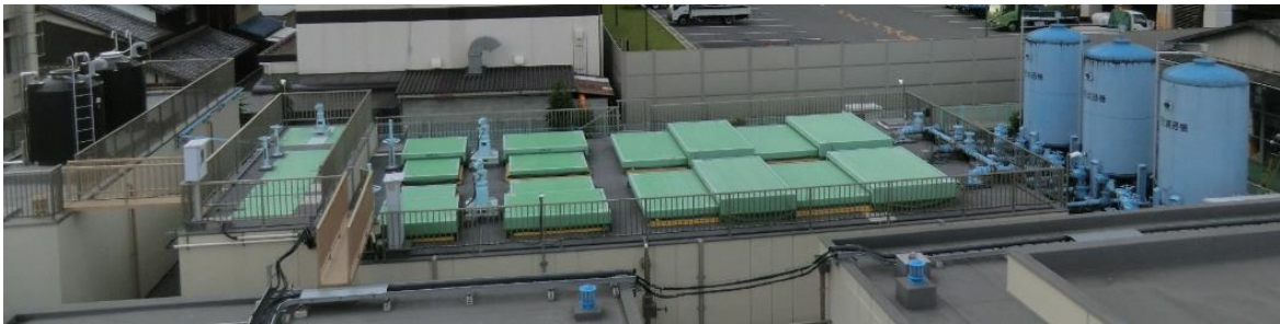
写真 2.1 佐古浄水場浄水施設全景
