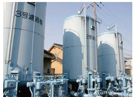
写真 2.5 急速ろ過機
