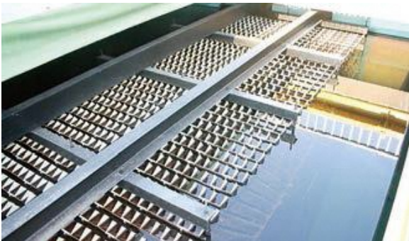
写真 2.4 傾斜板沈澱池
