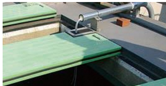
写真 2.3 着水井と塩素注入器
