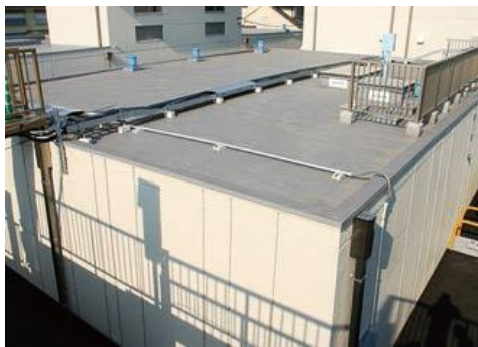
写真 2.6 佐古浄水場配水池
