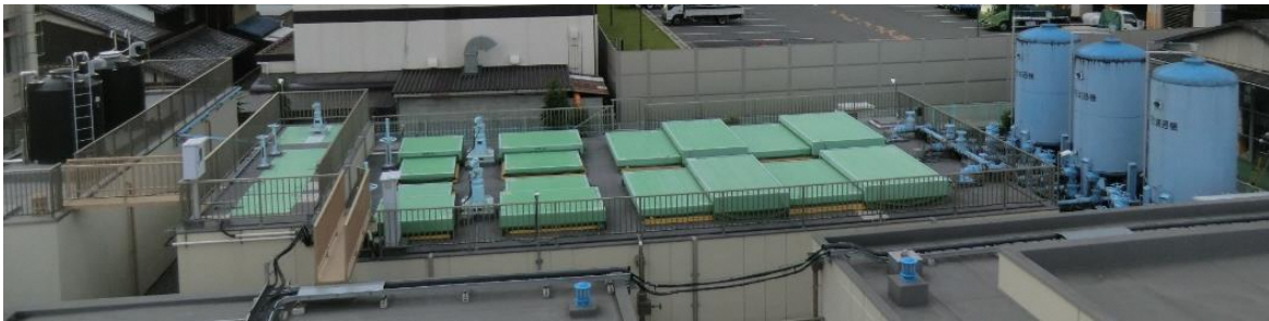
写真 2.1 佐古浄水場浄水施設全景
