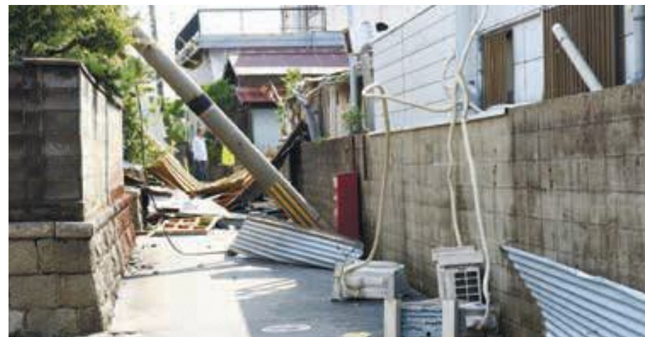
平成30年の台風21号で被害を受けたまちの様子
