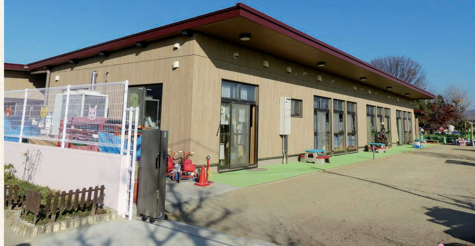
▲完成した南側増築新園舎
