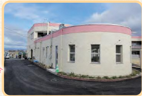
改修後旧園舎 外観
